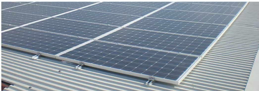
Slika 4 FN paneli na krovu
